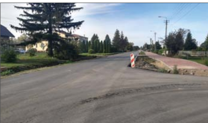
Remont ulicy Kościuszki
