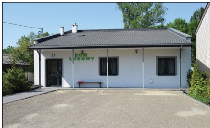
Zakończono remont w Domu Ludowym
