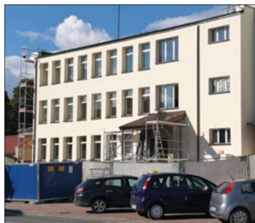
Dobiegają końca prace remontowe Urzędu Miejskiego w Bełżycach, które związane są z termomodernizacją tego budynku.
