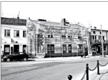
W bełżyckim Rynku trwa remont dachu jednej z miejskich kamienic.
