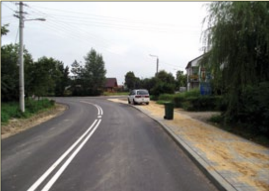
Droga Bełżyce - Strzeszkowice
