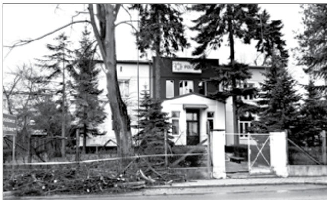
Komisariat w Bełżycach zmienia swój wygląd. Niedawno zakończono remont elewacji i przycięto gałęzie zasłaniające budynek.
