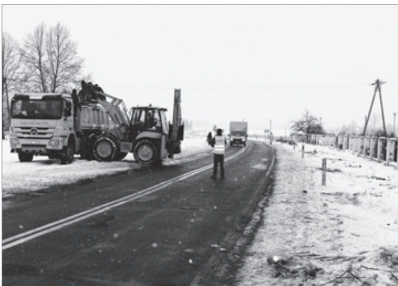
Demontaż ogrodzenia przy Domu Pomocy Społecznej w Matczynie
