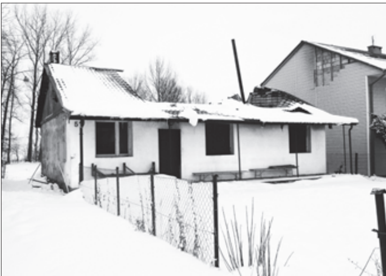
Budynek świetlicy kilka tygodni po pożarze
